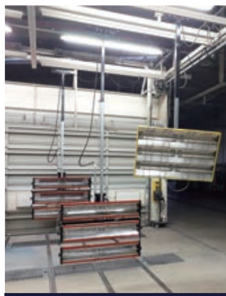
▲既存レール使用し、Tバーから入替工事
